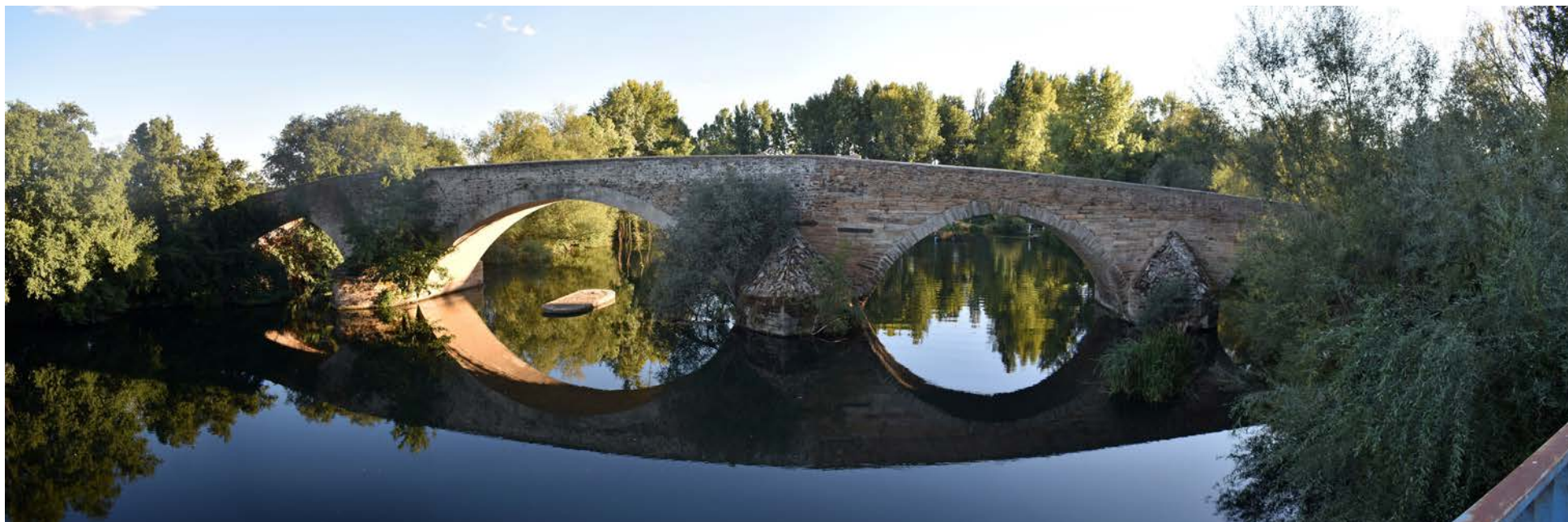
Vista general del puente desde el norte
