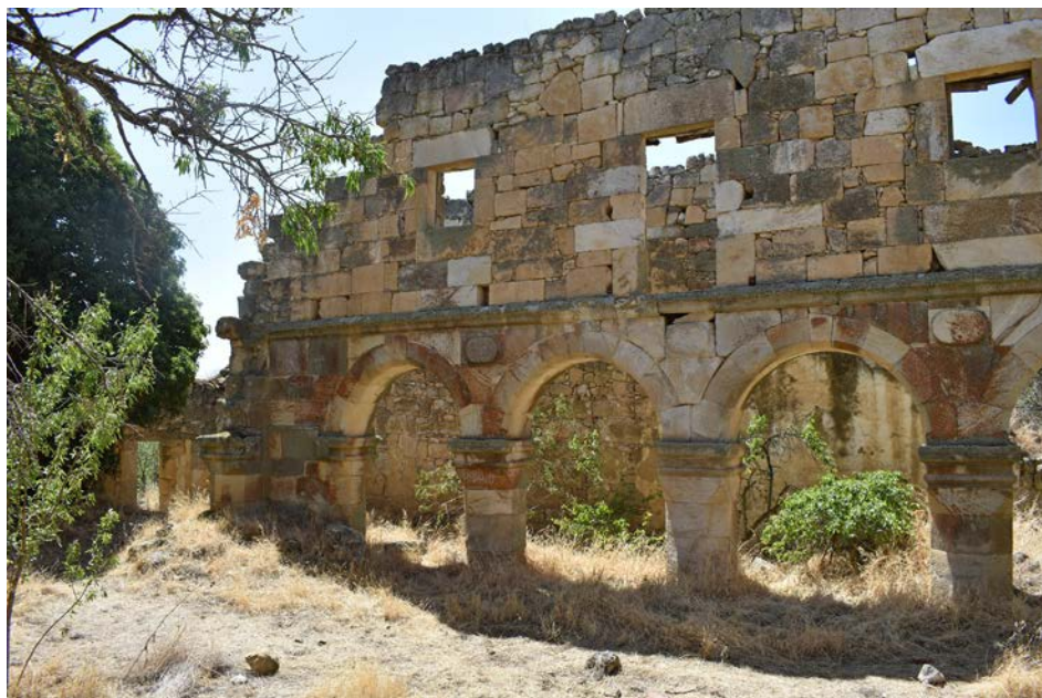
Visa interior y exterior del claustro con sus dos alturas y arquerías
