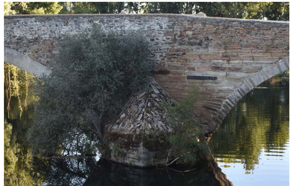
Detalle de una de las pilas y tajamares del puente desde cada lado
